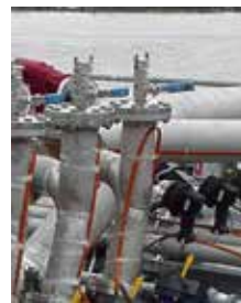
Tankschiff-Deck mit Begleitheizung im Bau
